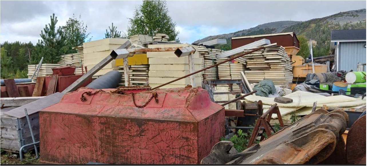
Kuva 13. Kiinteistölle KUNNAN-MÄNNISTÖ varastoituja purkujätteitä ja työkoneita.
