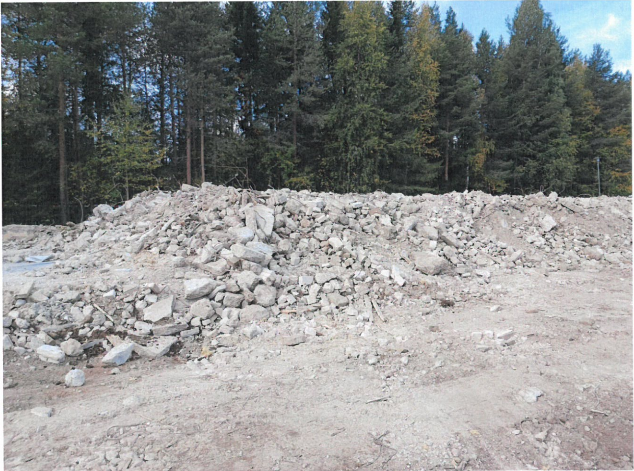
Kuva 1. Purkubetonia varastoituna työmaan itälaidalle.
