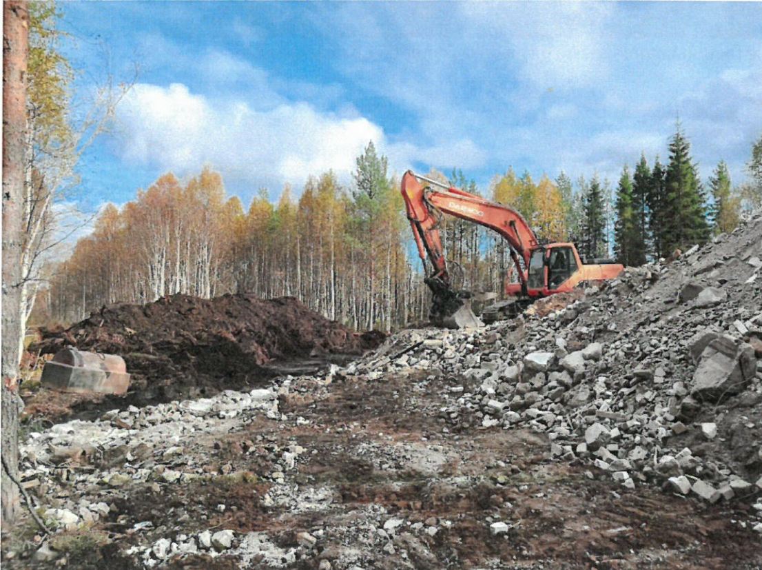
Kuva 3. Osa betonista oli jo levitetty ja tampattu rakennettavalle alueelle.
