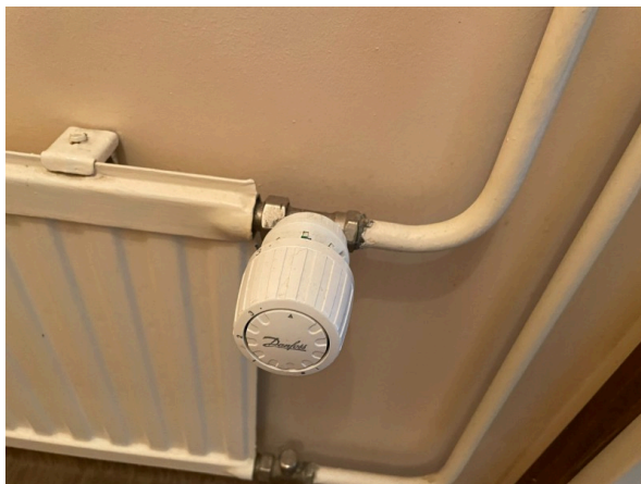
38. Termostaattinen patteriventtiili.
