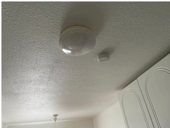
80. Huoneiston paristokäyttöinen palovaroitin.
