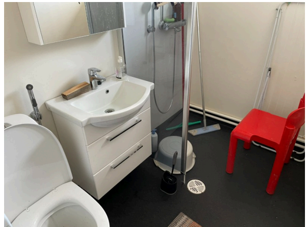
47. Remontin yhteydessä uusittuja vesi- ja viemärikalusteita.
