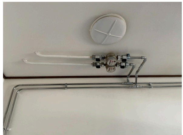
42. Huoneistokohtaiset vesimittarit (kylmä ja lämmin)
