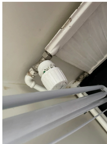
39. Termostaattinen patteriventtiili.
