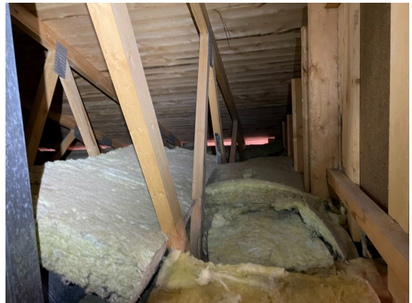
28. Yläpohjatila tuulettuu räystäältä.
