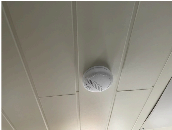
78. Yhteisen tilan paristokäyttöinen palovaroitin.
