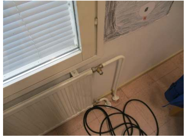
88. Rikkoutunut/puuttuva termostaatti
