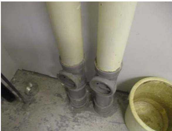
98. Muovi-/valurautaviemäroinnin rajapintaa 1. kerroksen lattian rajassa
