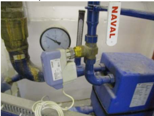
79. Uusittu toimilaite
