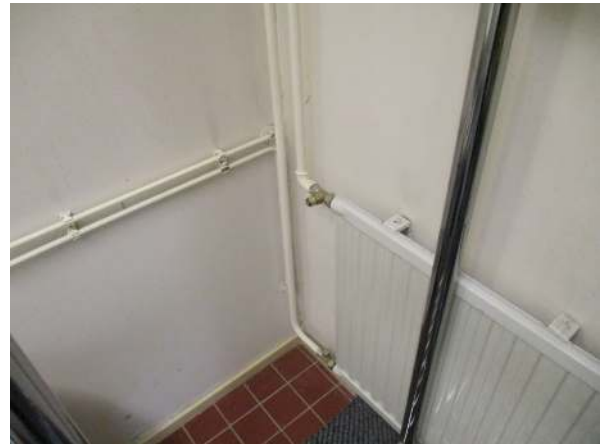
84. Yksittäisiä termostaattiosia puuttuu/on rikki
