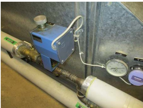
81. Alkuperäinen/vanha toimilaite
