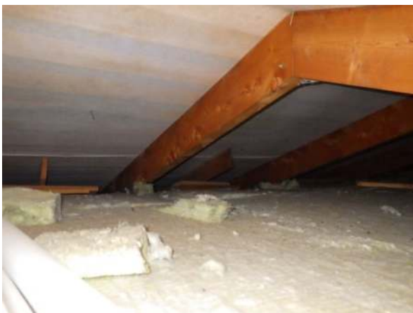
46. Yläpohjan tuuletusta, naula lävistää aluskatteen
