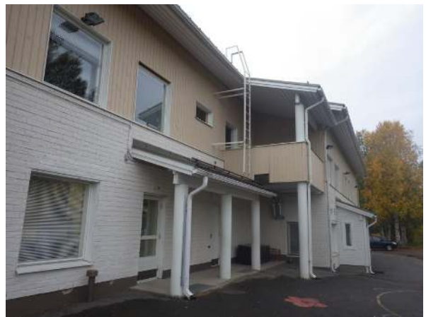
129. Rakenteisiin asennettuja valaisimia.
