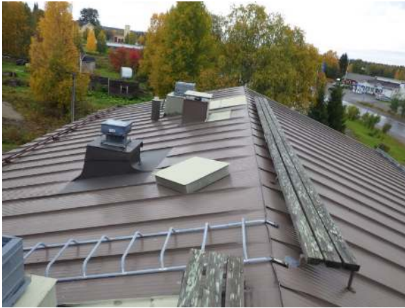
54. Kattosillat kiinnitetty suoraan peltikatteen läpi, kiinnityksiä tiivistetty.
