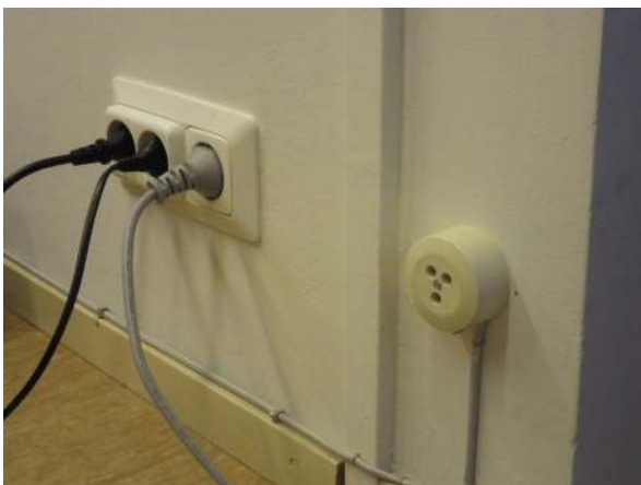
158. Alkuperäinen perinteinen puhelinverkko.
