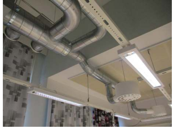
117. Uusittua ilmanvaihtokanavointia varusteineen
