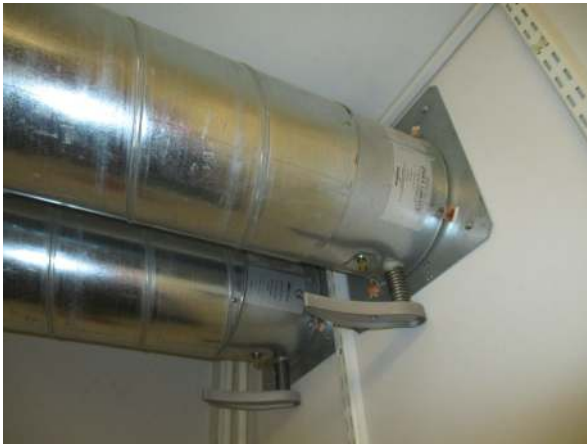
120. Uusittua ilmanvaihtokanavointia varusteineen
