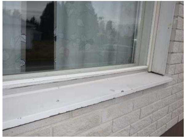
32. Ikkunapellissä maalihilseilyä.
