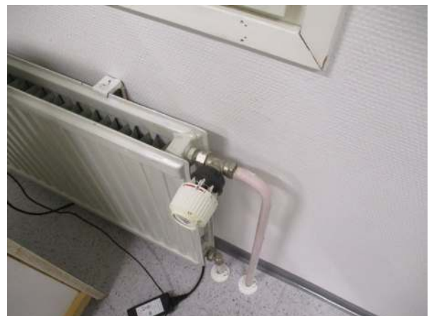
86. Uusittu patteriventtiili
