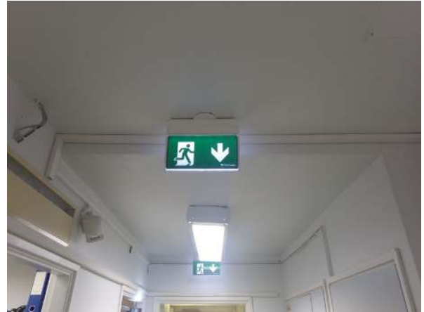
149. Uusittuja poistumistievalaisimia.
