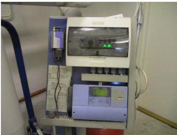
77. Lämmönjakokeskuksen säädin
