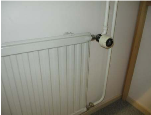
87. Alkuperäinen patteriventtiili
