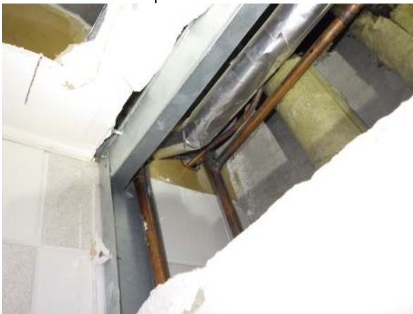
5. Putkivuoto välipohjassa 1krs. (136) pesuhuoneessa, korjaus käynnissä
