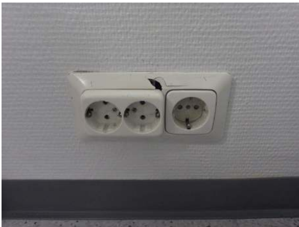
142. Rikkoutunut pistorasia luokassa 201 tulee uusia mahdollisimman pian.
