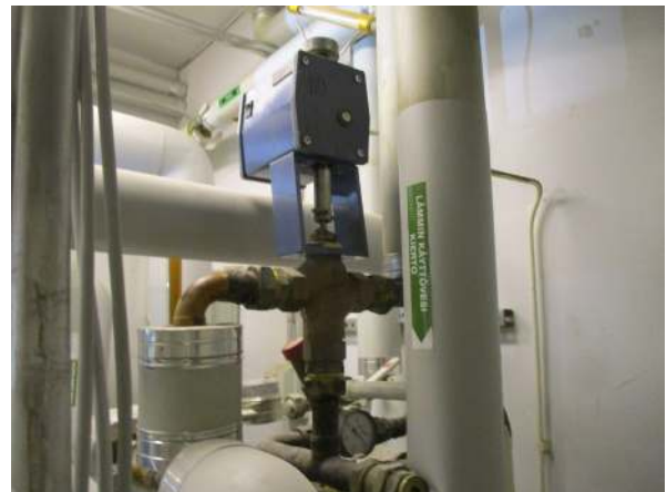
80. Alkuperäinen/vanha toimilaite
