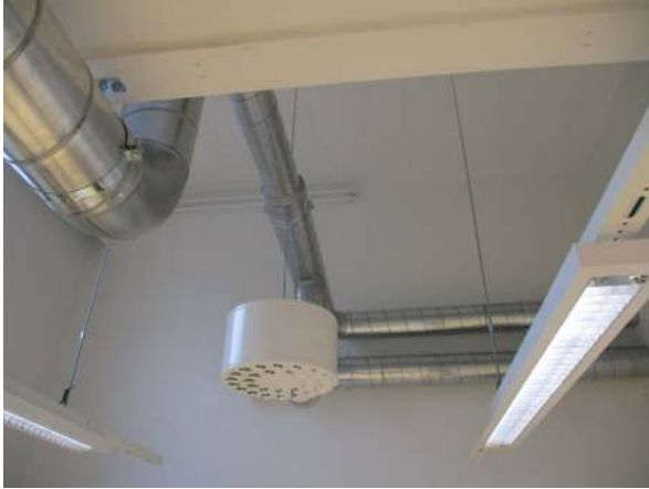
116. Uusittua ilmanvaihtokanavointia varusteineen
