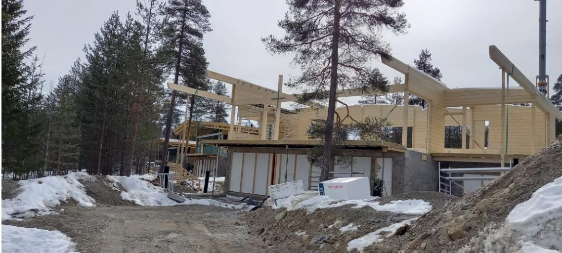
Kuva 16. Kuva rakenteilla olevista lomarakennuksista. Kuva J.Lokio.
