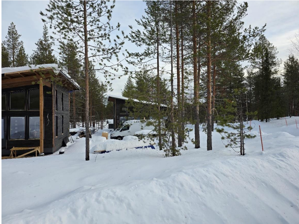
Kuva 8 Rakennuspaikan 1 rakentaminen on edistynyt (Kuva: Kimmo Mustonen, 7.2.2025)
