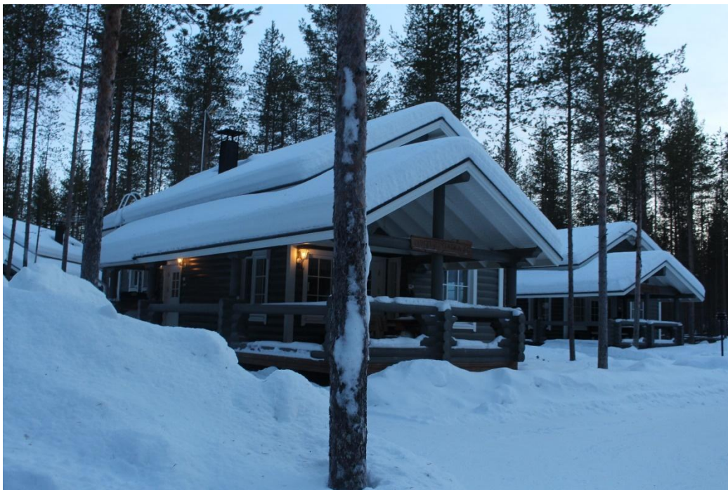
Kuva 18. Suunnittelualueen itäpuolen rakennuskantaa Uusipalon varrella, 23.1.2022.
