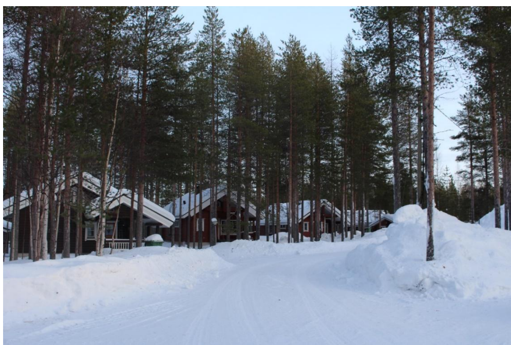
Kuva 17. Suunnittelualueen itäpuolen rakennuskantaa Uusipalon varrella, 23.1.2022.
