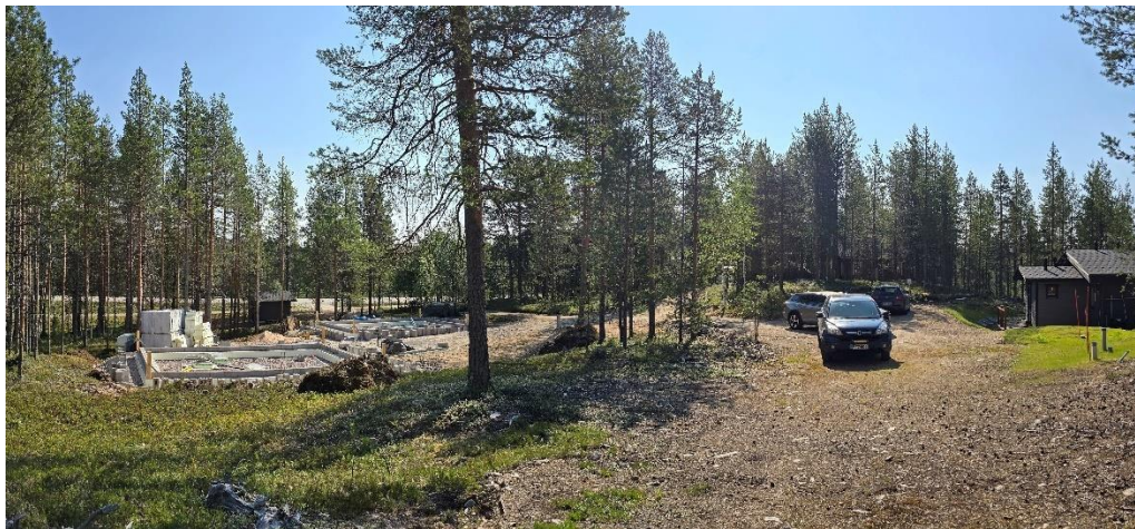
Kuva 7 Vasemmalla rakennuspaikan 1 työmaa, oikealla valmiit lomarakennukset ja taustalla Pyhäntie (Kuva: Kimmo Mustonen 25.7.2025)
