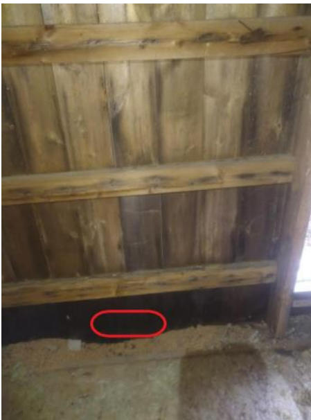
Kuva 21: PAH-näyte otettiin ullakolta kohdasta, jossa tuulensuojatervapaperia oli näkyvillä.
