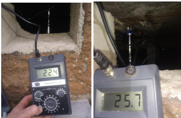
Kuvat 4 ja 5: Puurakenteiden kosteus pitoisuus ylitti sallitun 18p%:n rajan koko alapohjan alueella
