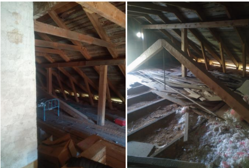
Kuvat 12 ja 13: Käyttöullakon kantavat rakenteet ovat hyvässä kunnossa.
