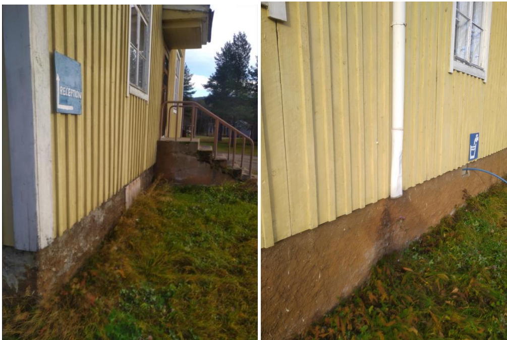
Kuvat 2 ja 3: Betonisokkeli on pieniä puutteita lukuun ottamatta tyydyttävässä kunnossa.
