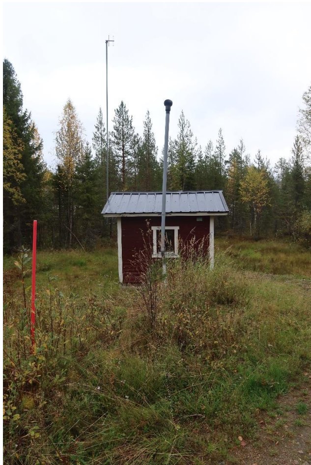
Kuva 9 Pumppaamo ET -alueella muutosalueen pohjoispäässä
